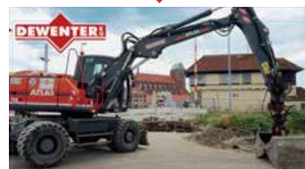
Bauvorhaben Poeler Straße
