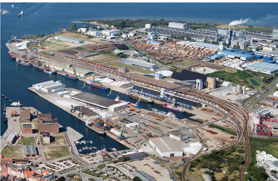
Auf dem Haffeld siedelten sich in den letzten Jahren mehrere große Holz verarbeitende Unternehmen an.
